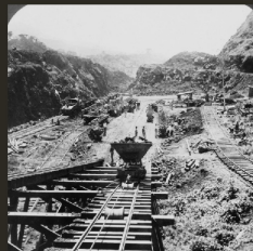
IL CANTIERE DEL CANALE DI PANAMA
